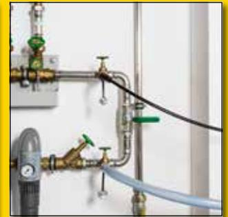
Druckprüfung mit Wasser (SLW)
